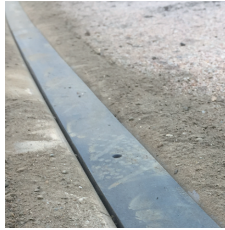
養生後の様子
